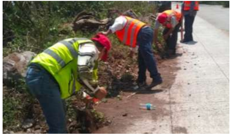
Imagen 20 Mantenimiento Red de Agua potable
