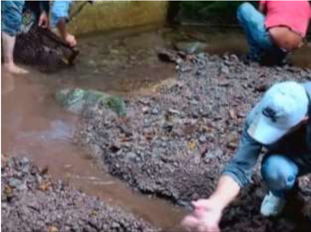
Imagen 19 Mantenimiento Red de Agua potable
